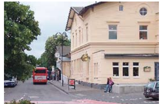
Eurode Bahnhof Herzogenrath
